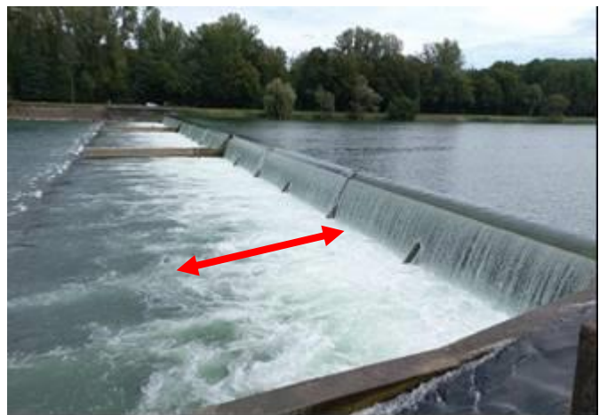
Seuils fixes déversants à l'aval des barrages de Marckolsheim, Rhinau et Gerstheim
